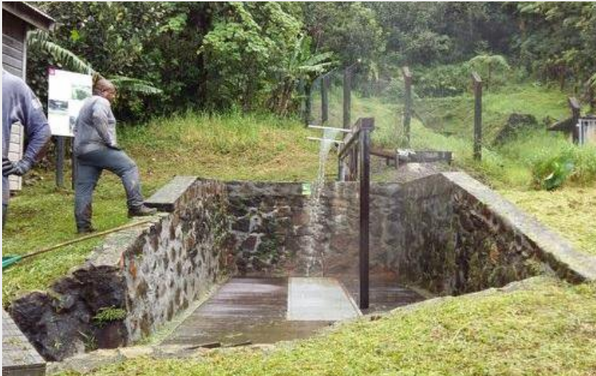
site des Bains Chauds (PNG)
